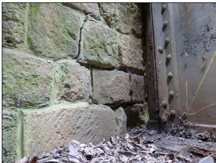
Obr. č. 7 – Opěra O 02 – závěrná zed' – trhlina a zvětralý kámen v pravé části, výsun zdiva
