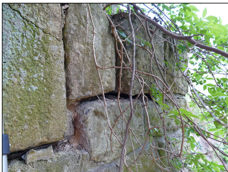
Obr. č. 8 – Opěra O 02 – úložný práh – vypadané spárování v pravé části
