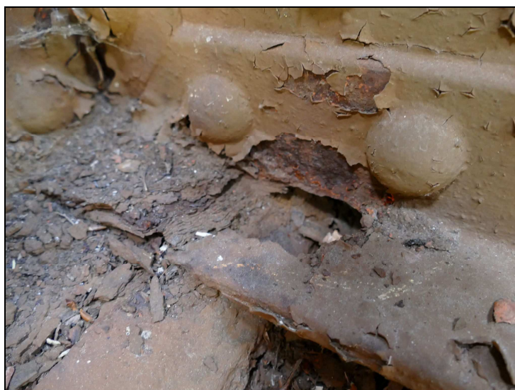
Obr. č. 2 – Konstrukce K 01 – příčné ztužení č. 1 – prokorodovaný úhelník vpravo
