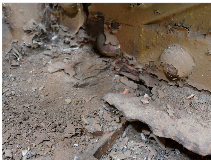
Obr. č. 3 – Konstrukce K 01 – příčné ztužení č. 7 – prokorodovaný úhelník vlevo
