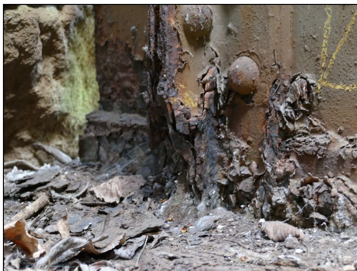
Obr. č. 1 – Konstrukce K 01 – prokorodovaná svislá výztuha pravého hlavního nosníku na konci
