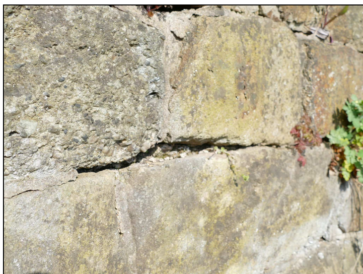
Obr. č. 9 – Opěra O 02 – křídlo vlevo – vypadané spárování
