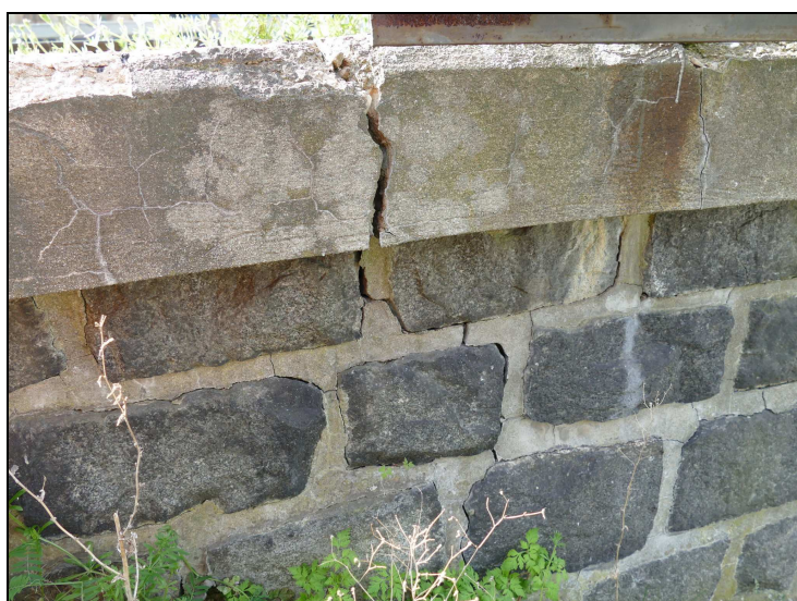
Obr. č. 6 – Opěra O 01 – přechodová zídka vpravo – odtržení
