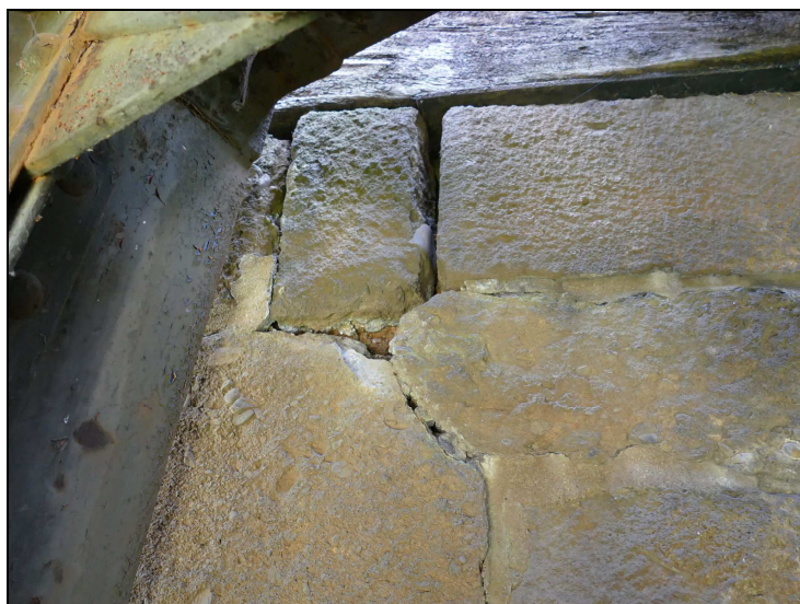
Obr. č. 4 – Opěra O 01 – závěrná zed' – vypadané spárování
